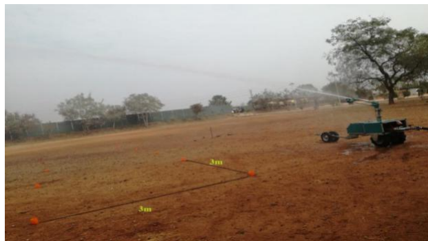
Fig. 1. Traveller Rain Gun (Sprinkler System).
